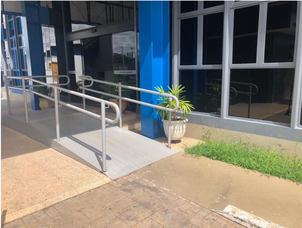
Rampa de acesso para cadeirantes
