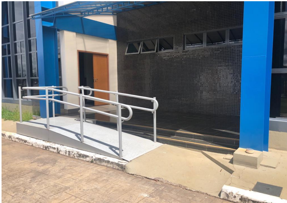
Rampa de acesso para cadeirantes
